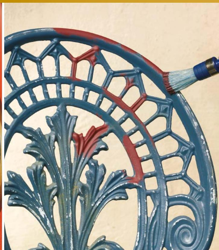
Грунт специально разработан для усиления адгезии финишного покрытия к цветным металлам, таким как алюминий, оцинкованная и нержавеющая сталь, хром, латунь и медь, а также дерево, пластик, стекло и пластмассы.
